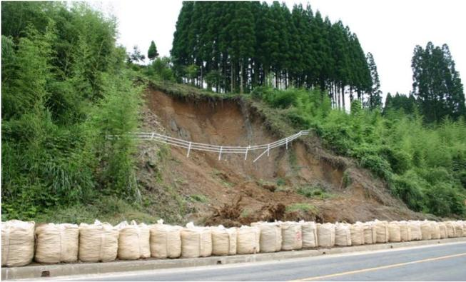
写真-6 強風化花崗岩（まさ）の崩壊
