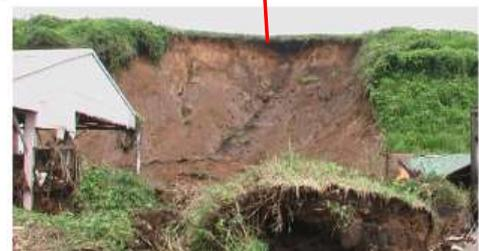
写真-5 阿蘇火砕流堆積物の風化非溶結軽石凝灰岩の斜面崩壊。断層が通過。（幅30m×長さ35m×深さ5m、1人死亡、山都町）
