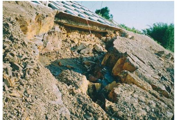
写真- 9 古第三紀の坂瀬川層の頁岩の流れ盤斜面の崩壊（岩盤すべり）。（天草市有明町）
