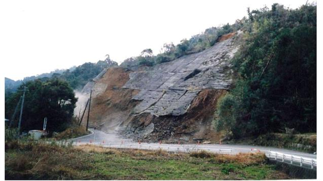
写真- 8 白亜紀の姫浦層群の頁岩の流れ盤斜面の崩壊。
