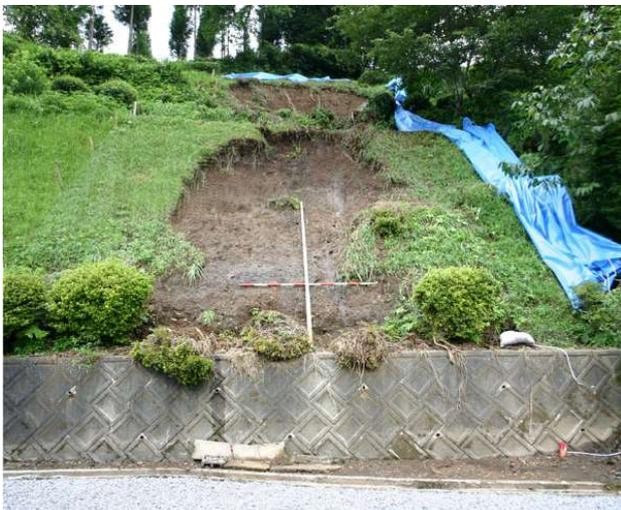
写真-2 阿蘇火砕流堆積物の非溶結凝灰岩の斜面崩壊（平成18年6月、山都町下市）
