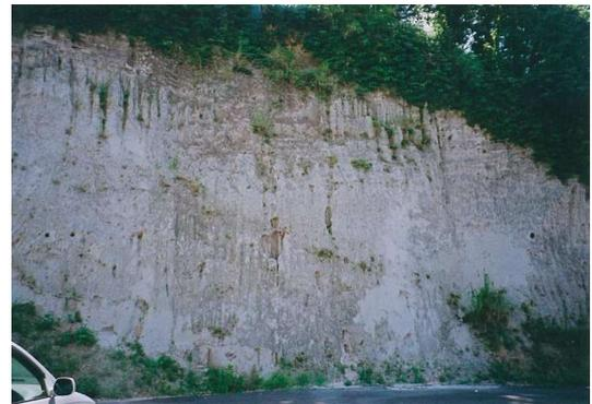
写真-4 始良火砕流堆積物の非溶結軽石凝灰岩のガリー侵食（水俣市古城）
