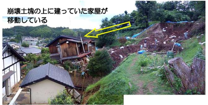
写真-3 阿蘇火砕流堆積物の非溶結凝灰岩の斜面崩壊（平成13年6月、山都町下市）
