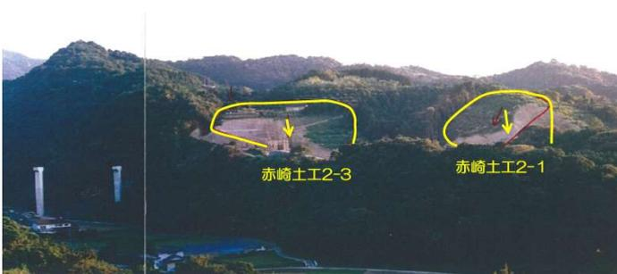
赤崎土工2-1: 崩積土層の地すべり及び流れ盤をなす頁岩層の岩盤すべり(幅50m×長さ50m×深さ8m程度)
